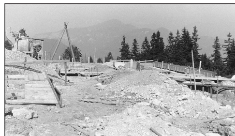
Stavba hornej stanice kabínkovej lanovky Malinô Brdo.
